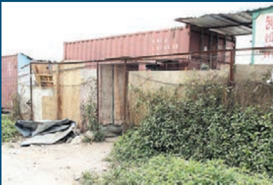
■鐵皮屋後的貨櫃實為裝有巨大油罐的售油裝置。
