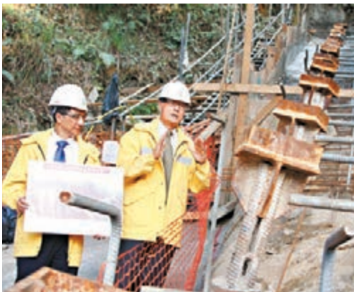
由於灣仔半山地勢狹窄，署方首次興建泥土引導牆，將泥石引至石壩。黃偉邦攝
