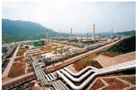
■亞洲最大的天然氣淨化廠——普光天然氣淨化廠。 本報四川傳真
