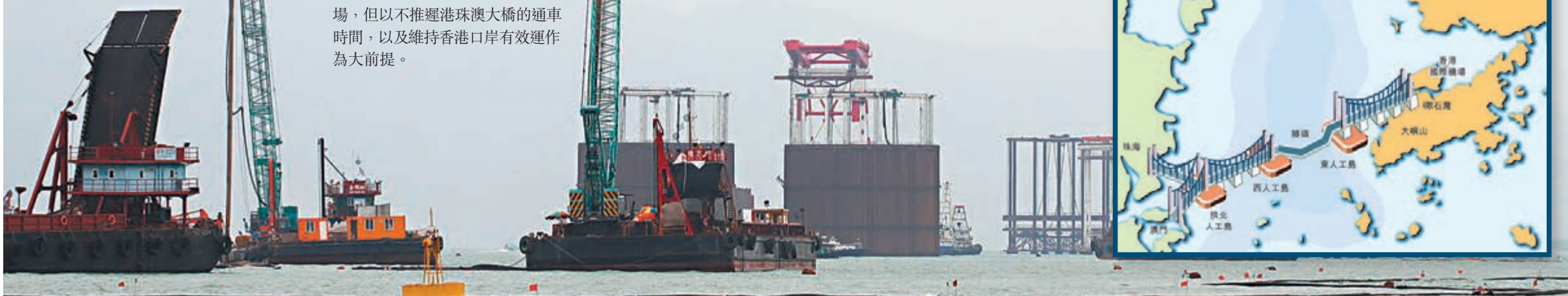
■港珠澳大橋香港口岸人工島施工現場。黃偉邦 攝
