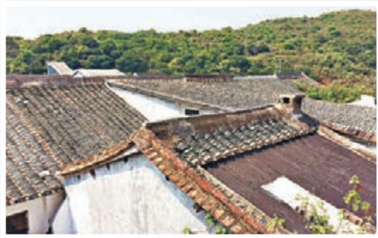
絕無僅有的瓦頂屋，在塔門仍處處可見。
