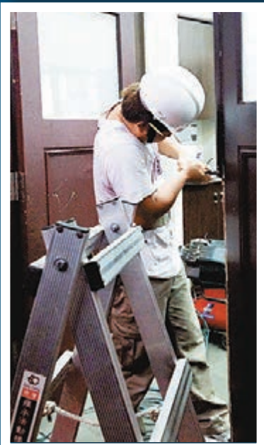
■裝修人員修繕「行政院」內遭破壞的窗戶。中央社
