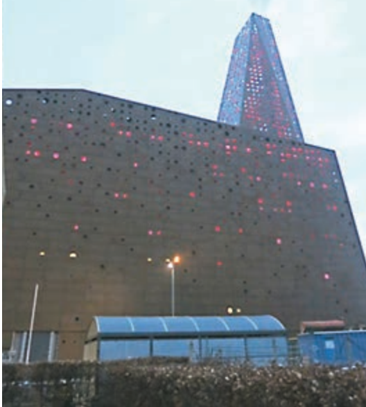
Roskilde 牆上開有無數圓孔,到晚上燈光會從圓孔透出,焚化爐成燈光舞台。資料圖片
