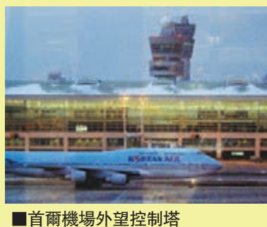
■首爾機場外望控制塔
