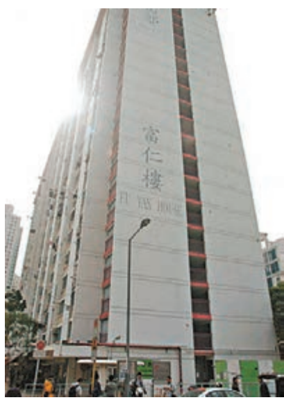
房委會完成檢討22條高樓齡屋邨重建潛力,發現屋邨結構狀況基本良好。圖為富山邨富仁樓。資料圖片
