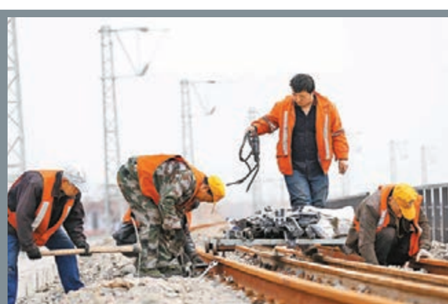
山西黃韓侯鐵路施工 黃韓侯鐵路侯西段電氣化複線施工進展順利，工人在黃韓侯鐵路侯(馬)西(安)線山西新綫境內工地上施工。黃(陵)韓(城)侯(馬)鐵路是連接陝西中部與山西南部的重要能源運輸通道，爲國鐵一級電氣化鐵路。新華社
