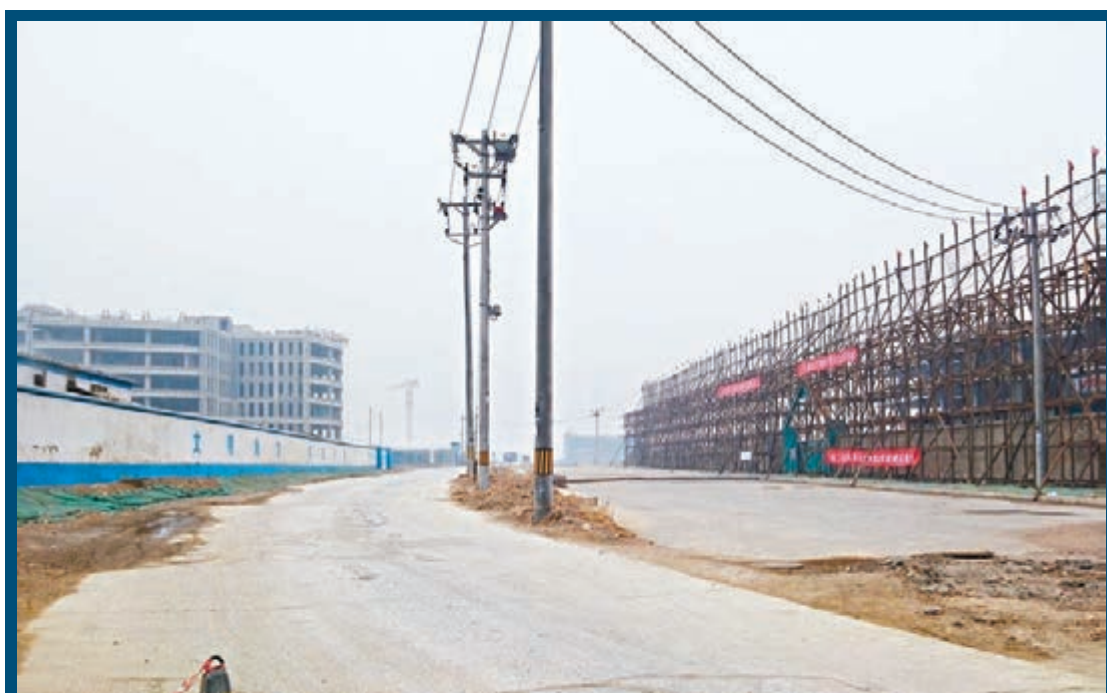
北京市一處停工的工地。
