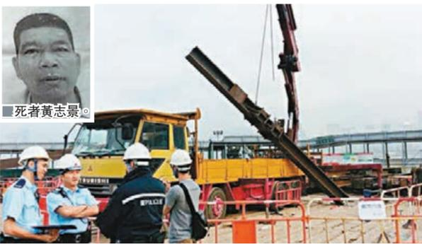
吊臂車用以吊起巨型工字鐵的兩條鋼纜斷了一條。
