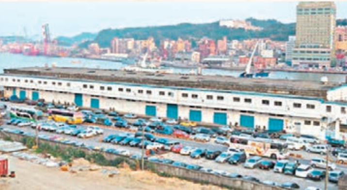
■基隆港西三碼頭倉庫面臨拆除。網上圖片
