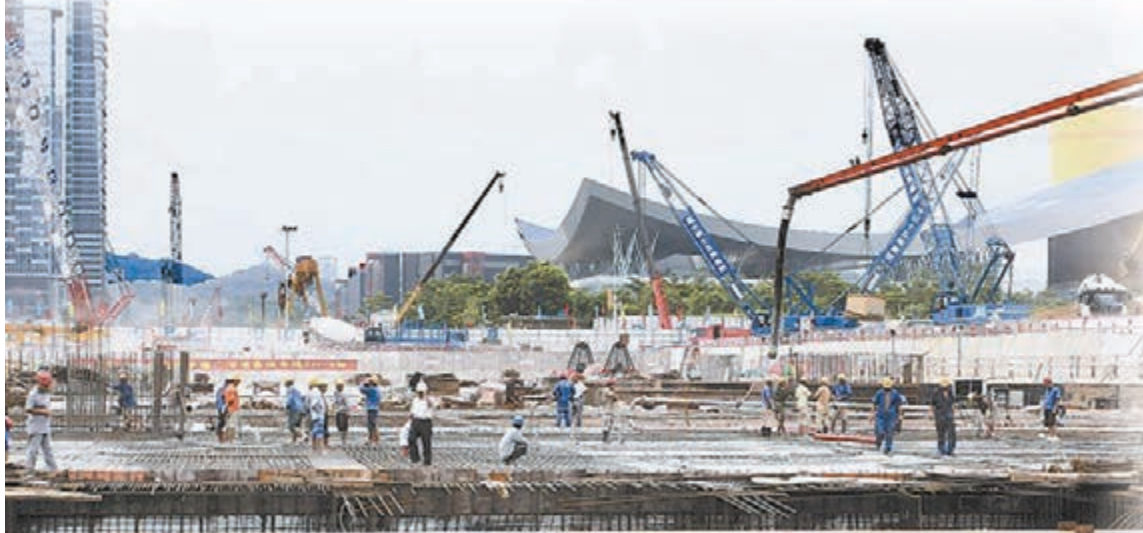
■深圳將建設總面積達178平方公里的12個重點區域。圖為新建地鐵站工地。 資料圖片
