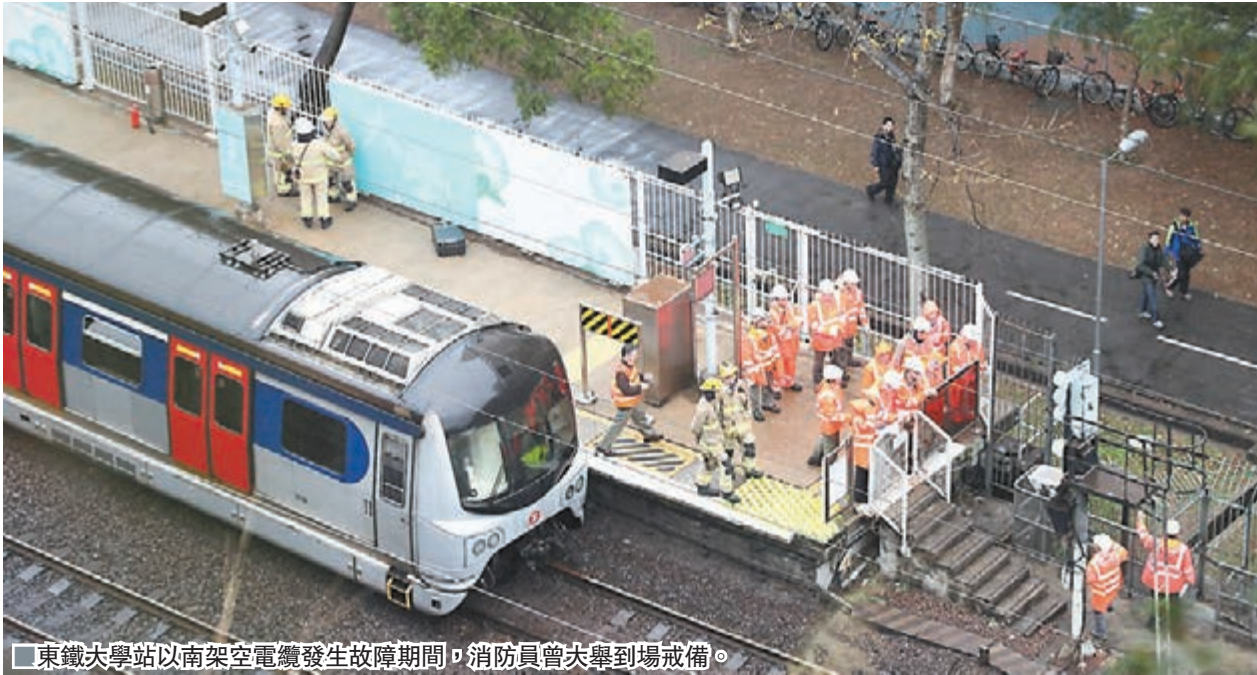
東鐵大學站以南架空電纜發生故障期間，消防員曾夾舉到場戒備。
