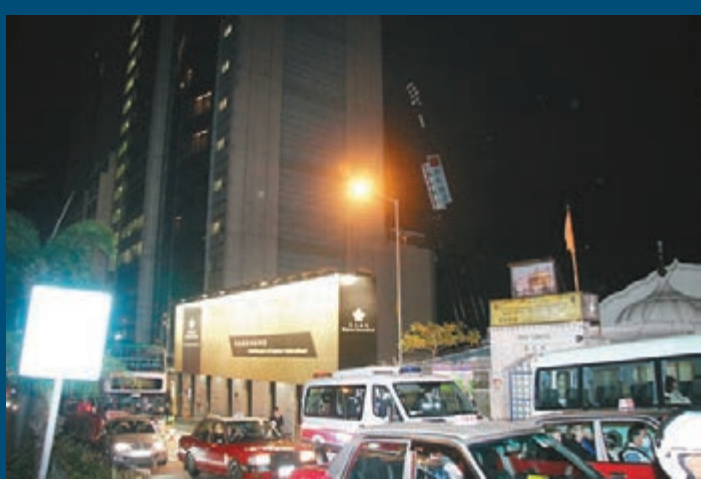
發現戰時美製大炸彈出土地盤正進行地基工程。
