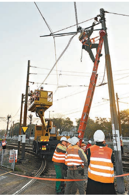
■工程人員在輕鐵坑尾村與塘坊村之間的架空電纜進行緊急搶修。
