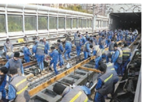
■上海鐵路曾經發生類似沉降問題。圖為工人前年搶修發生沉降的地鐵4號線。網上圖片
