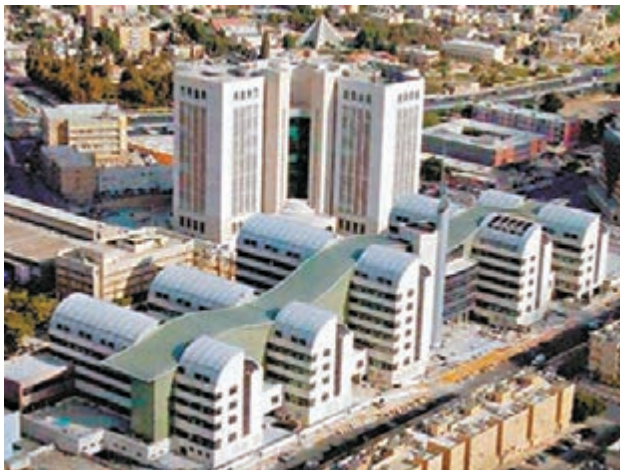
■青島青建集團承建以色列貝爾沙瓦市政府辦公樓。
