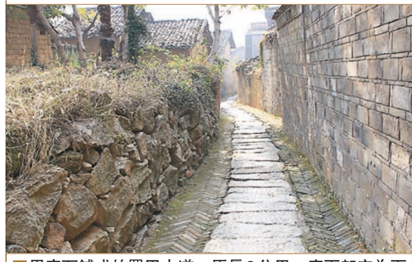
■用麻石鋪成的羅田古道，原長3公里，底下架空為下水道，穿街過巷。 本報記者王道 攝
