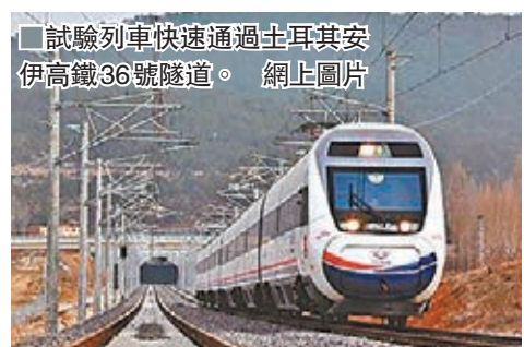
■試驗列車快速通過土耳其安卡拉伊高鐵路36號隧道。網上圖片
