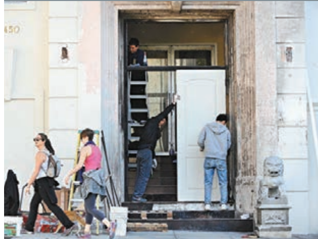
■中國駐三藩市總領館工作人員開始安裝正門，清理內外牆面和地面。中新社
