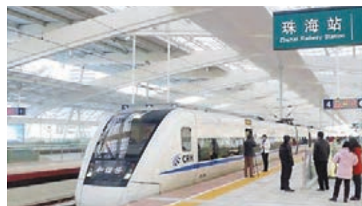
■廣珠城軌延長線擬月底開工。圖為珠海站。資料圖片
