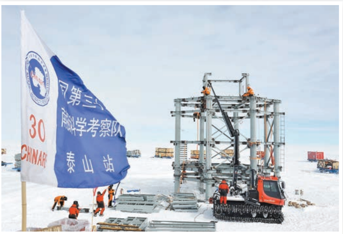
■中國南極泰山站鋼結構主體3日封頂。新華社
