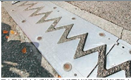
屯門公路去年螺絲釘凸出路面刺破重型車輪胎導致大塞車。政府估計,為伸縮縫基座磨損肇事。資料圖片
