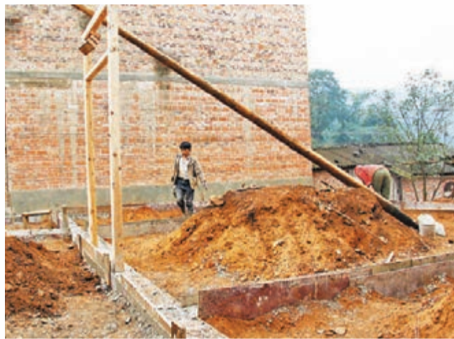
■工人正在建蓋阿靈家的新房。
