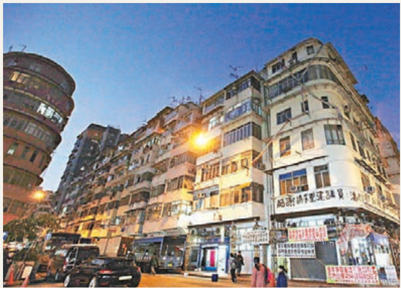
土瓜灣啟明街51號舊樓及相連唐樓，昨日被屋宇署發出清拆令後，市建局隨即宣布提前啓動41號至51號「需求主導」重建項目。
