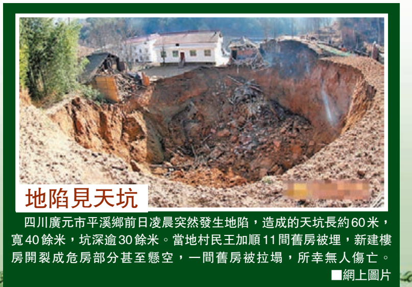
地陷見天坑 四川廣元市平溪鄉前日凌晨突然發生地陷，造成的天坑長約60米，寬40餘米，坑深逾30餘米。當地村民王加順11間舊房被埋，新建樓房開裂成危房部分甚至懸空，一間舊房被拉塌，所幸無人傷亡。網上圖片
