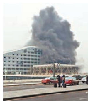
■在建酒店工地着火冒出濃煙。本報深圳傳真
