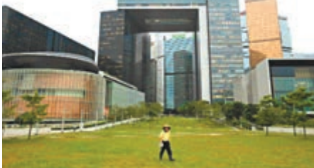
審計署指添馬艦工程在移交程序大致完成時，尚有88,960項缺漏。
