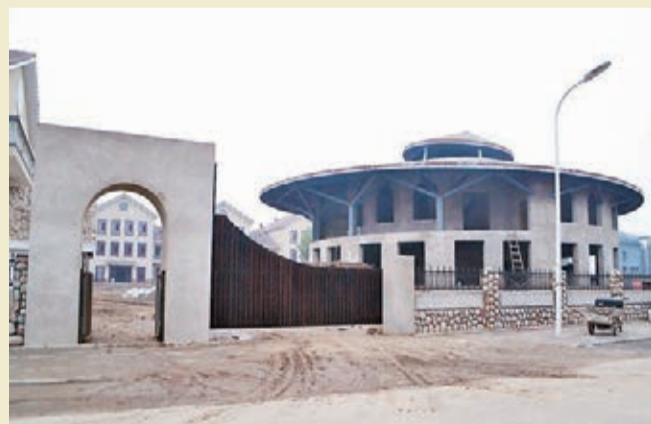
■ 正在施工的「非洲小鎮」主體建築。
