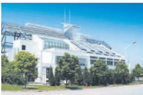
■ 建科院生態建築示範樓
