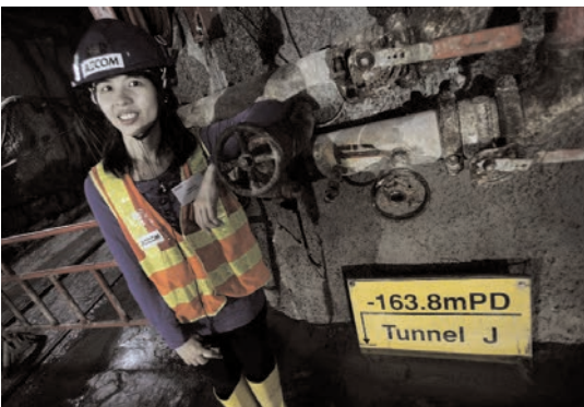
■污水隧道最低點達海平面以下163.8米，相等於樓高52層的怡和大廈。 梁祖彝攝
