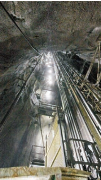
■豎井離地面達160米，籠梯上落每程需要約5分鐘。 梁祖彝攝
