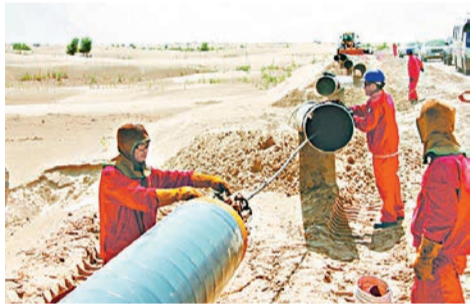
南疆天然氣利民工程施工現場。 本報新疆傳真
