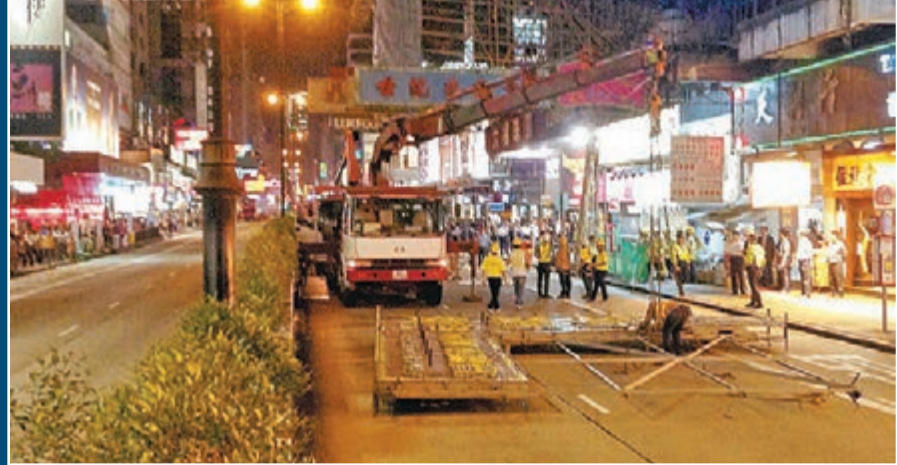
危險招牌由2架吊臂車一左一右拆下。
