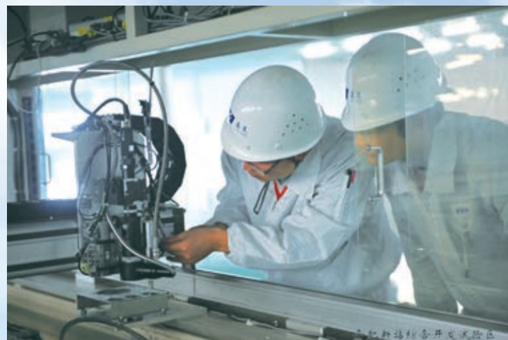
■ 鑫昊PDP項目正在進行設備安裝調試
