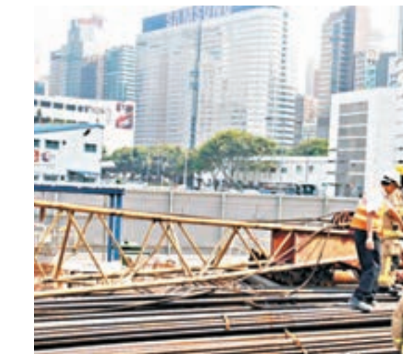
中環灣仔繞道地盤發生吊臂倒塌，工人向消防員講述經過。
