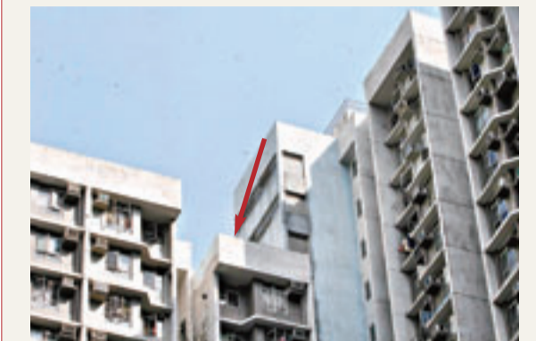
中四學生由樓高20樓天台跌落樓高17樓天台受傷被困之處。
