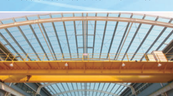
公司承建的鄭煤機集團車間及高端液壓支架項目。
