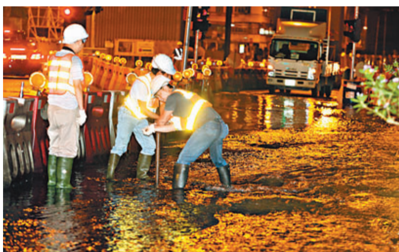
馬頭圍道近江蘇街地底鹹水管水浸，水務署人員到場關水掣。
