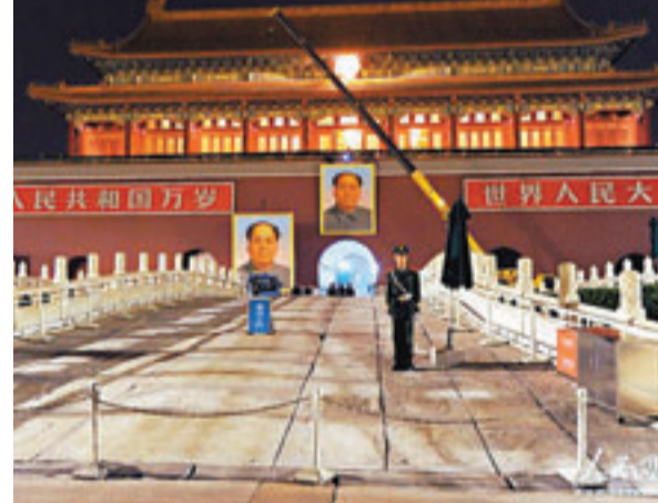
9月28日零點，天安門城樓開始了一年一度的更換新的主席像工作。工作人員用吊車把舊的毛主席畫像徐徐吊了下來，再把新畫像吊起來固定在城樓正中央。整個安裝過程僅用了一個小時。人民網
