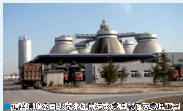
萬諾環境公司北京小紅門污水處理廠石灰處理工程
