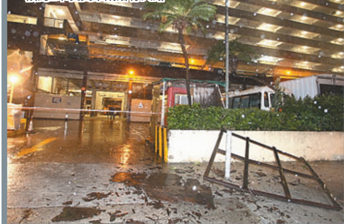
■屯門一正廈外牆維修工作平台倒塌，更有一段約2米長支架飛落行路。
