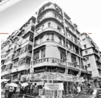
■土瓜灣啟明街51號唐樓被頒封樓令，住戶和商戶在樓宇外牆貼橫額呻苦。 資料圖片
