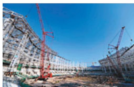
福州奧體中心主體育場鋼結構主體工程本月初封頂。
