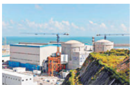
陽江項目1、2號機組工程現場。
