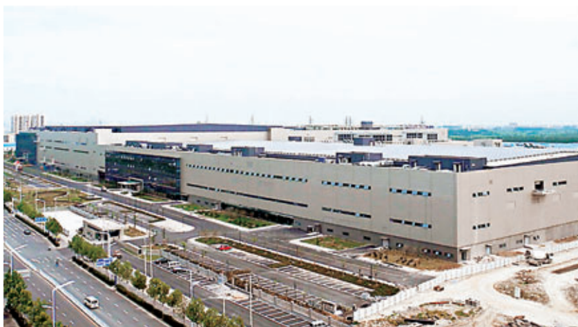
京東方8.5代線生產基地已進入設備安裝階段。
