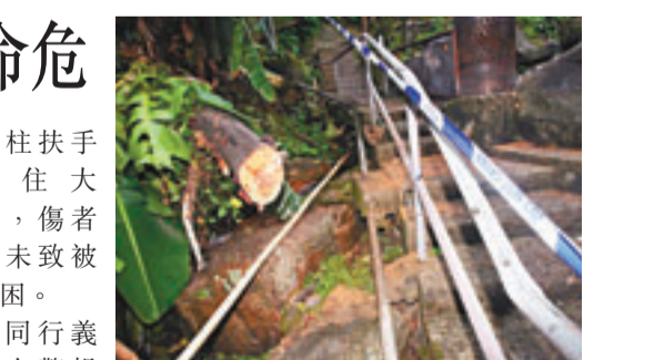
■倒塌大樹壓倒鐵欄杆(右),大樹事後被鋸斷移到一旁(左)。
