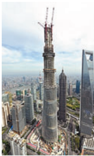
■上海中心大廈封頂航拍照片。本報上海傳真
