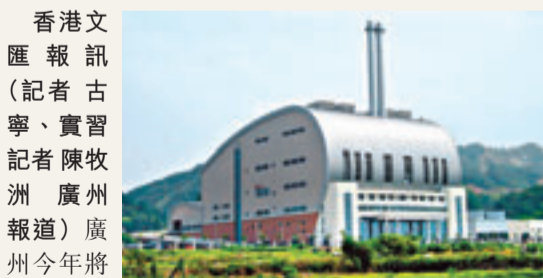
圖為廣州李坑生活垃圾焚燒發電廠。 本報廣州傳真
