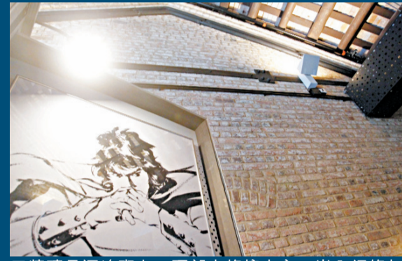
牆磚是逐塊砌上,頂部木條挖中空,嵌入鋼條加固,是本地首次採用相關技術。劉國權攝
